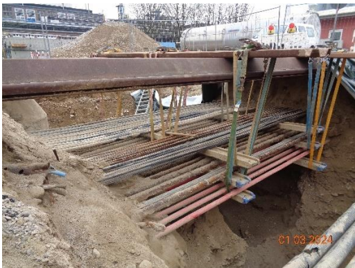
Beispielbilder Sicherungsmaßnahmen an freigelegten Kabeltrassen
