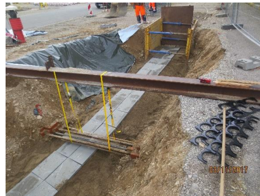
Beispielbilder Sicherungsmaßnahmen an freigelegten Kabeltrassen
