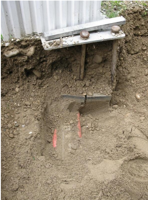
Kabelschaden verursacht durch Erdnagel
