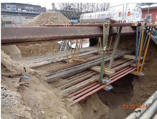
Beispielbilder Sicherungsmaßnahmen an freigelegten Kabeltrassen
