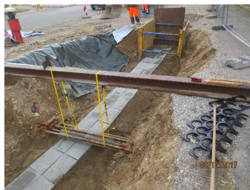
Beispielbilder Sicherungsmaßnahmen an freigelegten Kabeltrassen
