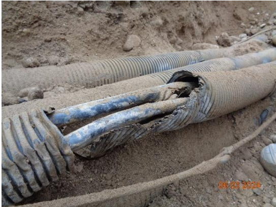
Kabelschäden
